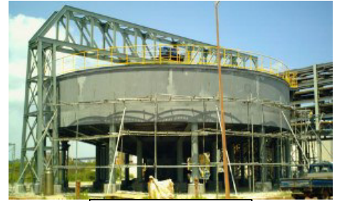
スラッジ濃縮槽
