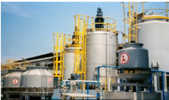
プラント拡張プロジェクト
